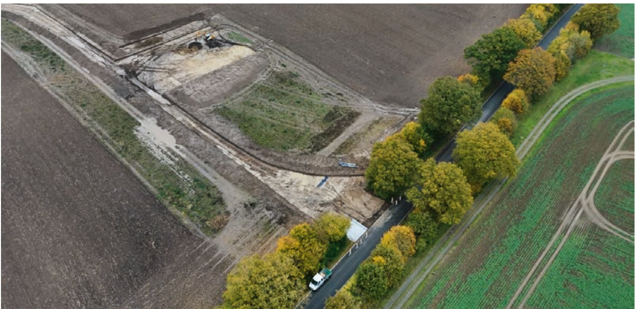
Bau der Zuwegung (links) im Windpark Quarnbek Erweiterung
