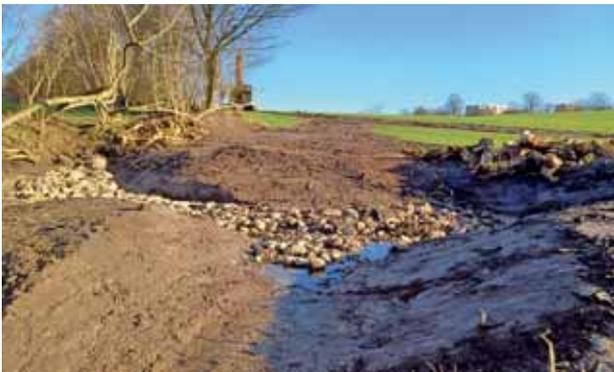
Beispiel: Ein vertiefter Zulauf wird mit gesammelten Feldsteinen aus der direkten Umgebung aufgefüllt. Darin siedeln sich kurzfristig Pflanzen an, so dass durchlaufendes Wasser geklärt wird.
